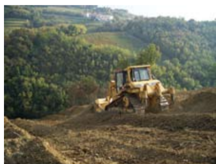
Lavori di sbancamento preliminari al ciglionamento del vigneto
