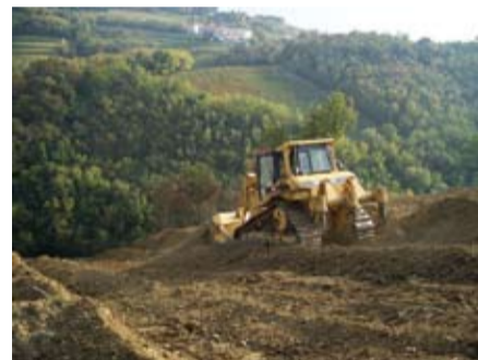
Lavori di sbancamento preliminari al ciglionamento del vigneto
